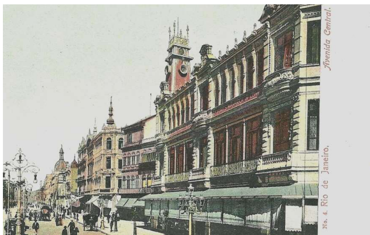
Figura 5: Esquina da Rua do Ouvidor com a Avenida Central. Cartão postal. Casa Staffa, Rio. Acervo particular.
