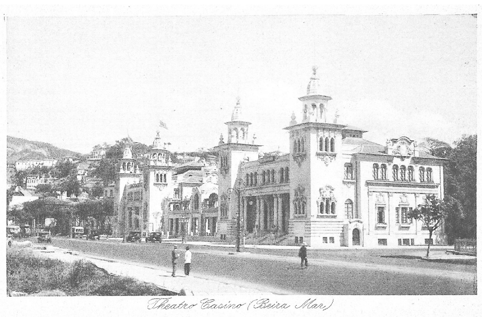
Figura 7: Na parte posterior do Passeio Público, de frente para o mar, havia dois edifícios, unidos por pérgulas, o Teatro – Cassino e o Cassino Beira- Mar.
